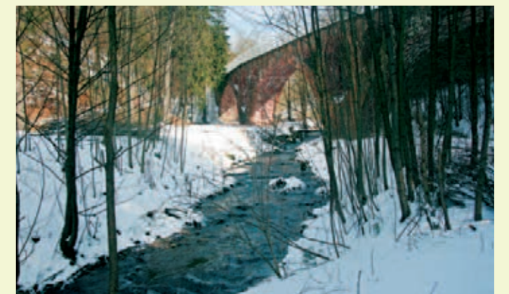
Die Schmalkalde am Viadukt 6
